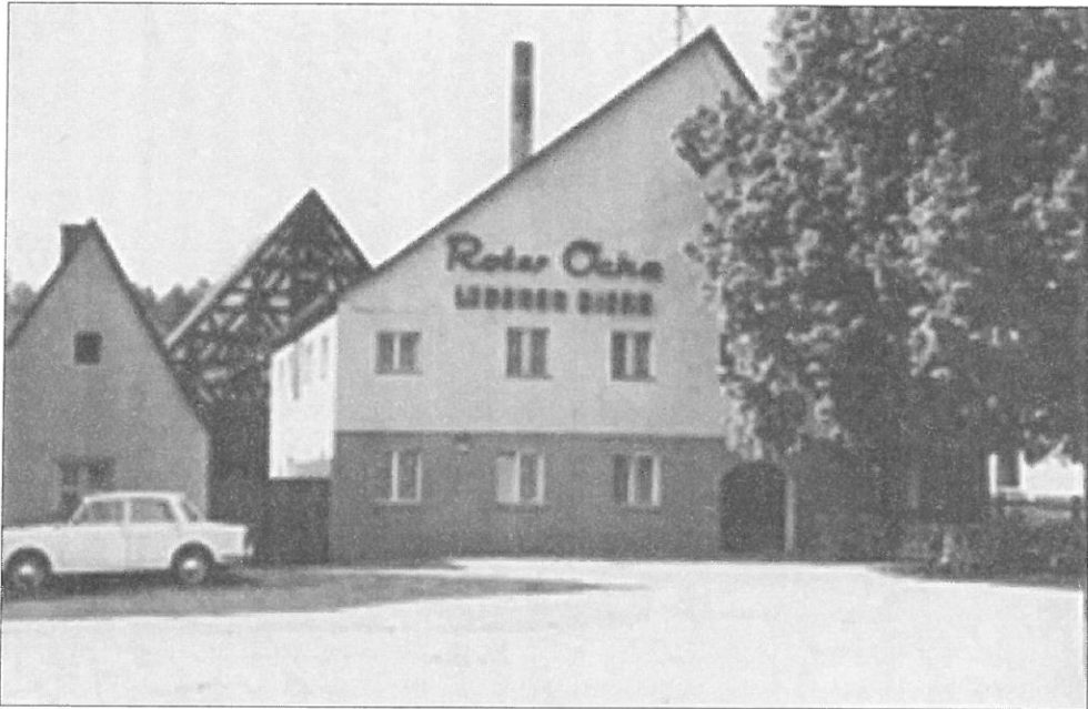
1. Rückersdorf. Der "Rote Ochs" hat, als Georg Wolfgang dort 1713 geboren wurde, sicher ähnlich ausgesehen...
